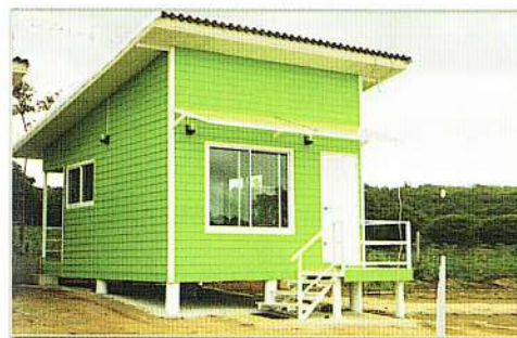
บ้านประกอบเสร็จ
